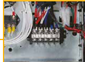
Dış ünite güç besleme terminal bloğu
